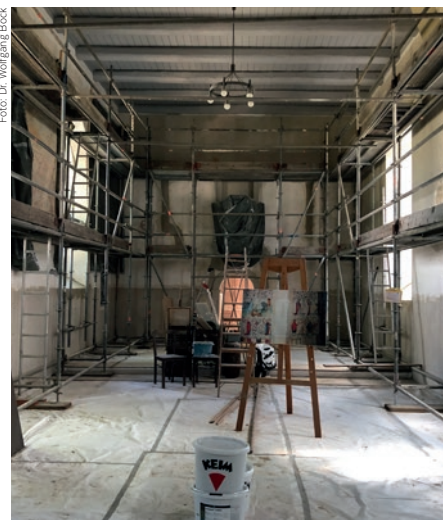
Impression zur Sanierung des Innenraumes der Kirche St. Bonifatius in Ackendorf; die Arbeiten sind inzwischen abgeschlossen.
